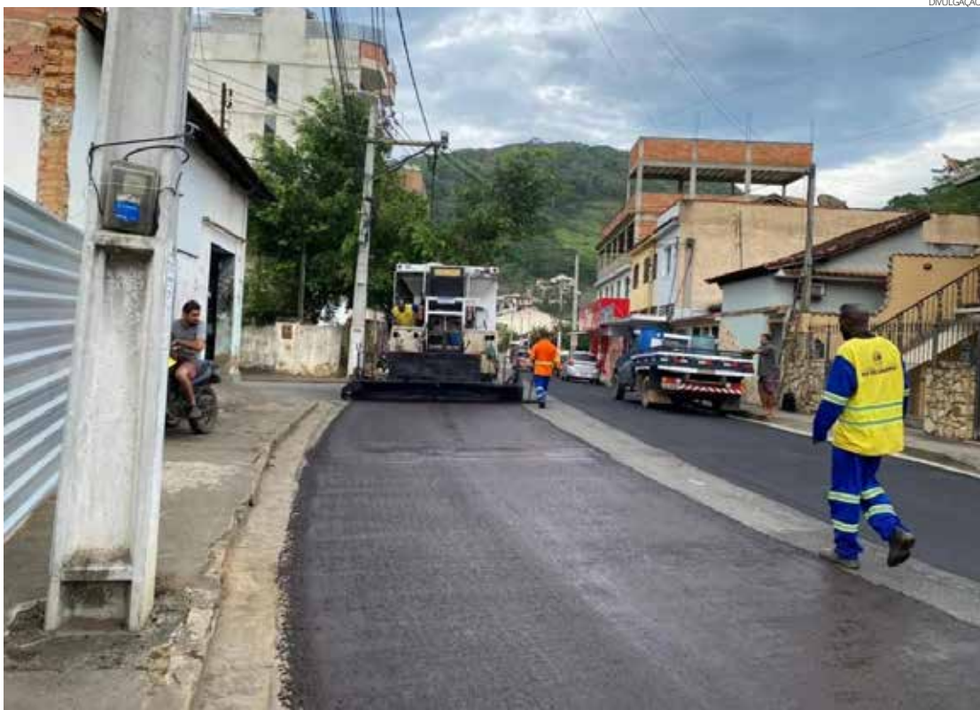
Máquinas fazendo o recapeamento de alfasto na Rua Bento de Andrade Lemos
