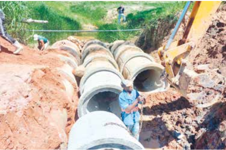
Funcionários da secretaria de Estradas e Rodagem realizado aplicação de novas manilhas na estrada da Cachoeira
