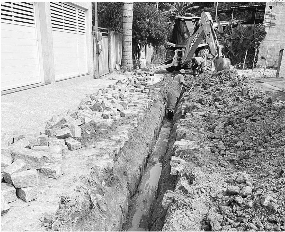
Bairro da Garapa recebe melhoramentos da prefeitura na rede de esgoto
